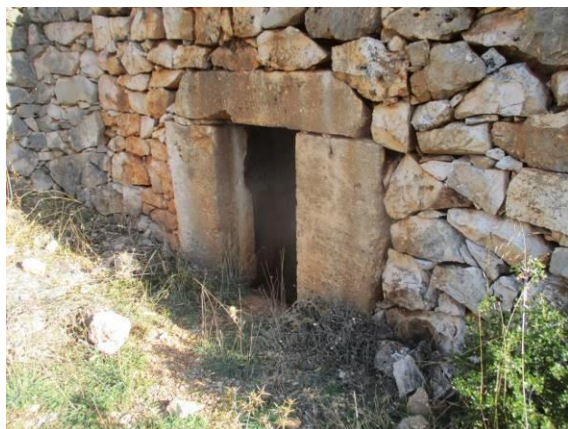
Fabricación y puerta adintelada.
